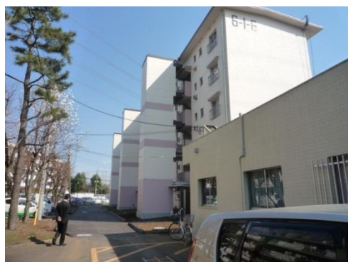
写真 中層エレベーターの設置された住棟
